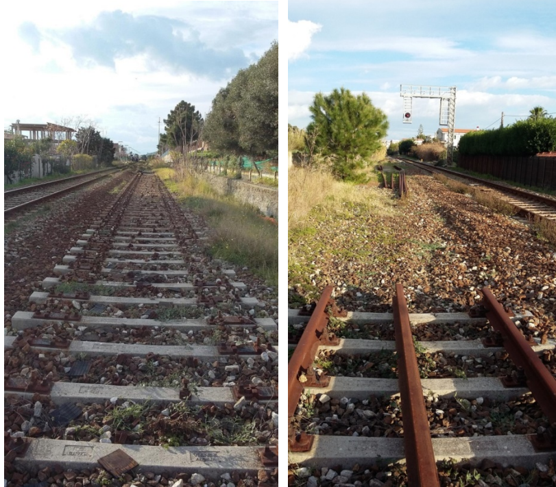
Soppressione del secondo binario nella stazione di Marina di San Lorenzo
