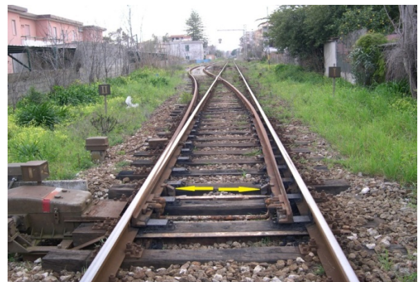
Blocco operativo di binario mediante morse (stazione di Ardore)
