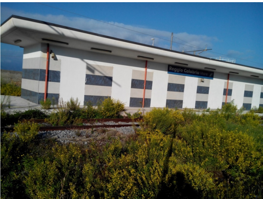
Stazione Porto Bunker
